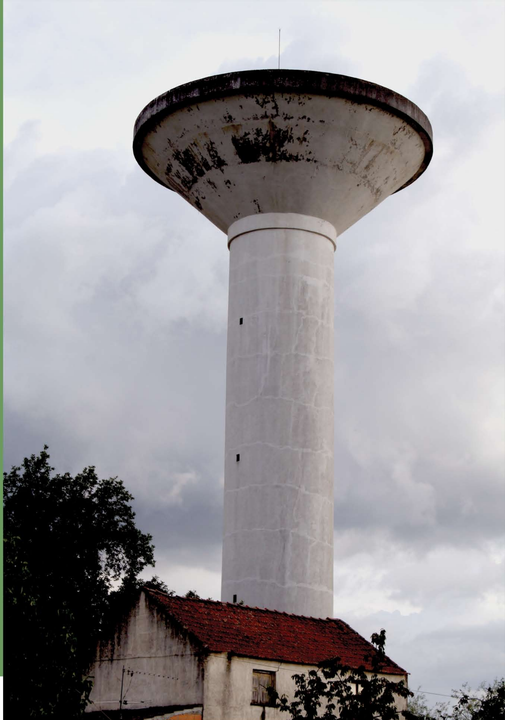
Reservatório de água de Espinho
