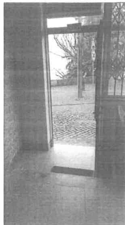
FOTO C - VISTA INTERIOR DEGRAU DE ACESSO NA PORTA PRINCIPAL
